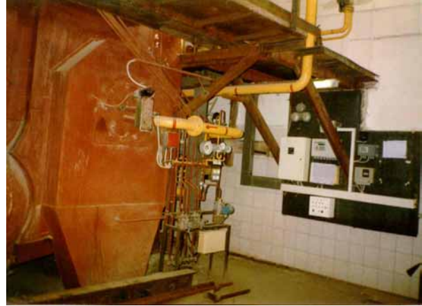
Рисунок 5,6. Котельная «Ликероводочный завод» г. Курск. Котел ДЕ-4 на газе.
