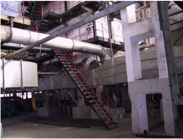
Рисунок 7,8. «СИБЗАВОД» г. Омск. Котел КВГ-30. Котел ПТВМ-30 (6-горелочный).
